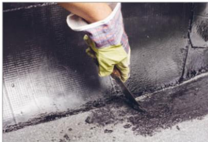
**!** **ВАЖНО!** Укладку верхнего слоя Техноэласт ЭКП на вертикальную поверхность нужно начинать с пониженных участков кровли. Вода должна стекать со шва в сторону ендовы.
