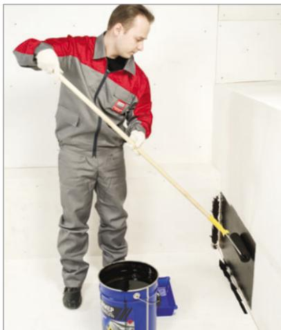
— Вертикальную поверхность основания из цементно-песчаного раствора, сборных стяжек (листы обрабатываются с двух сторон) и бетона необходимо обработать грунтовочными холодными составами (праймерами) для обеспечения необходимого сцепления кровельных материалов с основанием. В качестве грунтовки, наносимой на сухие поверхности, рекомендуется применять Праймер битумный ТЕХНОНИКОЛЬ №01.
