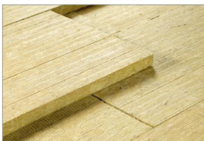
— При устройстве теплоизоляции из двух и более слоев плитного утеплителя швы между плитами располагайте «вразбежку», обеспечивая плотное прилегание плит друг к другу.
